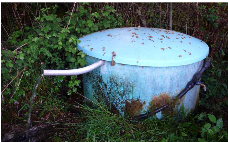
Vista general del depósito.
